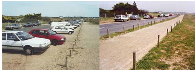
Comparaison avant et après travaux de la voie piéton/vélo le long du littoral (source : DOCOB du site FR5300059, 2010)
